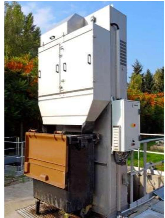
**Nouveauté** : dégrilleur avec ouverture de godet jusqu'à 1000mm
